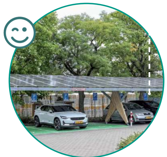
Appui de l'ombrière sur un alignement d'arbres côté nord
