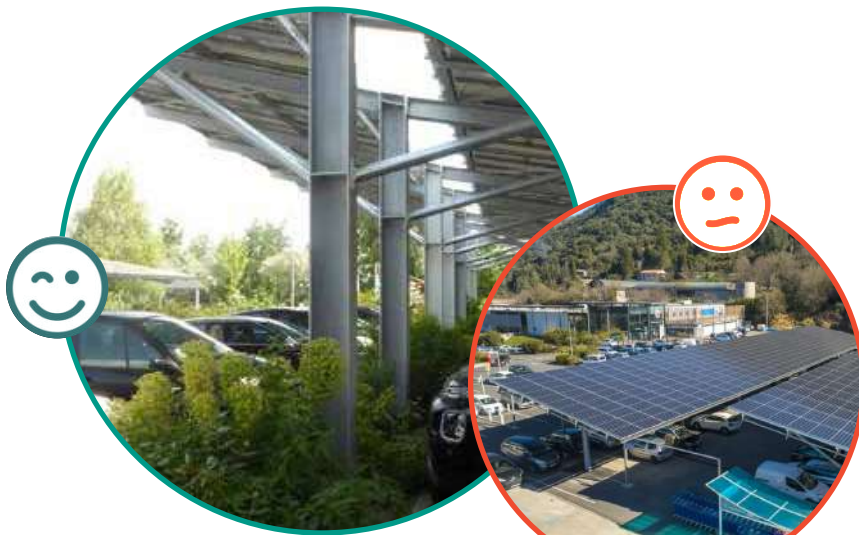
Bande plantée récupérant l'eau pluviale des panneaux
