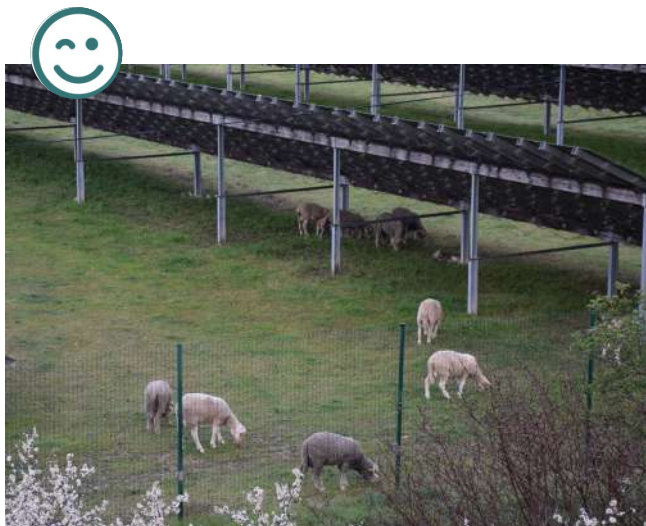
Exemple de structure de panneaux partiellement en bois à Sainte-Tulle. Gestion extensive par le pâturage.
